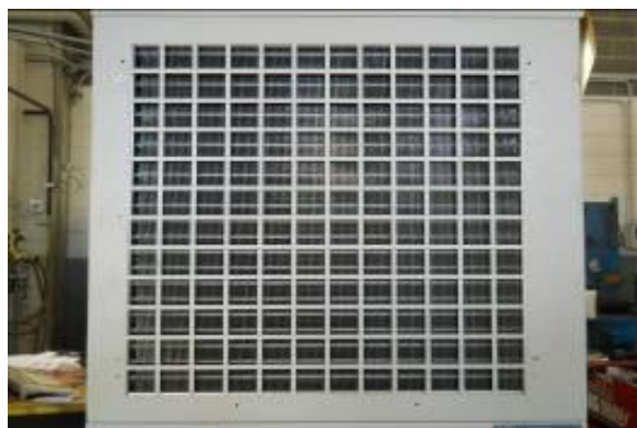
Figura 24 – Posición del filtro de aire
