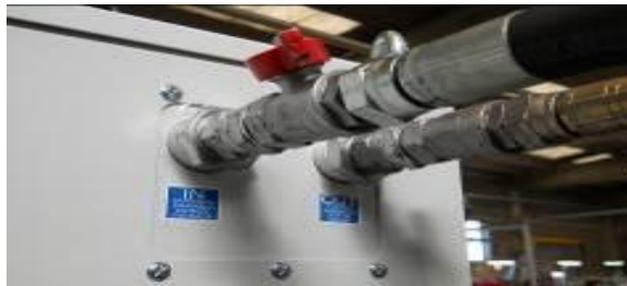
Figura 13 – Conexión de los tubos
