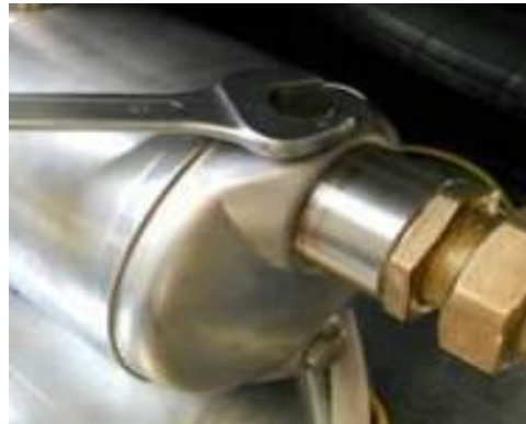
Abbildung 15 – Entlüften der Pumpe
