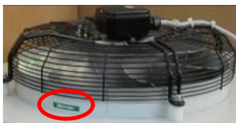
Figura 21 – Direzione di rotazione del ventilatore
