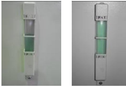
Abbildung 18 / 19 – Füllen des Tanks
