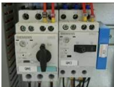
Figura 20 – Tutti gli interruttori di circuito su ON
