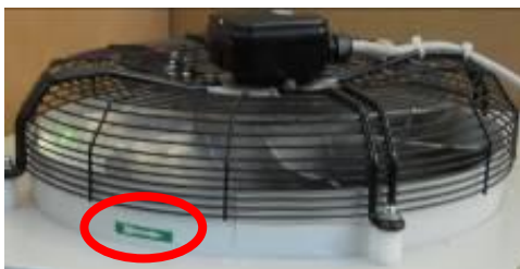
Figura 21 – Dirección de rotación del ventilador
