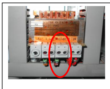
Figure 5 Transformateur réglé sur 400V
