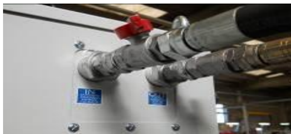
Abbildung 13 – Anschluss der Schläuche
