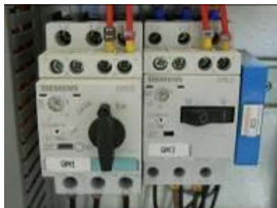
Figura 19 – Tutti gli interruttori di circuito su ON
