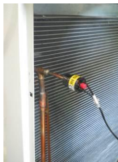
Реле высокого давления
