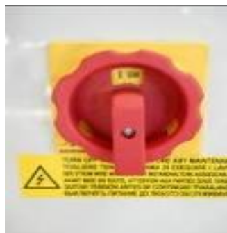
Рис. 16 – Главный выключатель ВКЛ.
