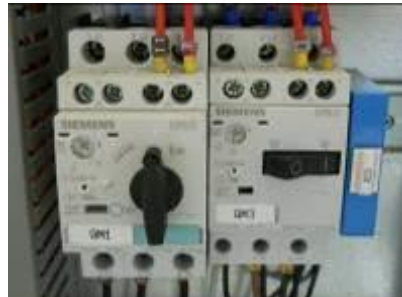
Рис. 19 – Все выключатели контура ВКЛ.
