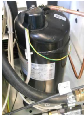
Рис. 21 – Положение компрессора
