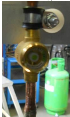
Указатель жидкости
