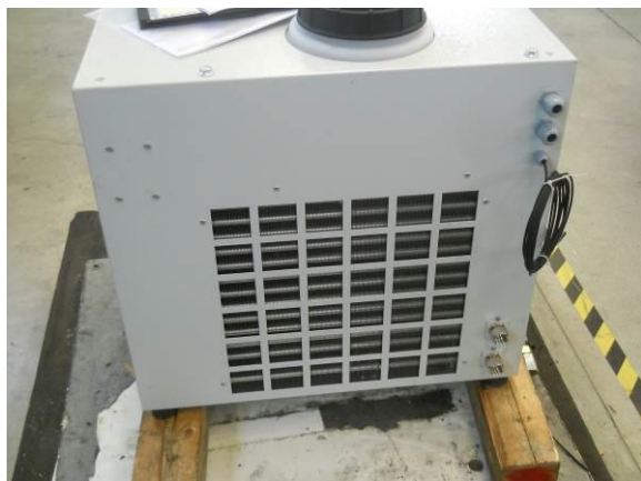
Picture 20 – Superficie externa del condensador para CCE 6101 – 6201 – 6301
