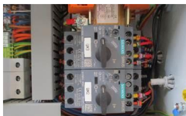
Abbildung 12 – Pumpenschalter auf ON
