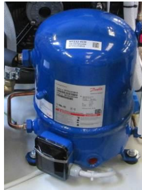
Рис. 17 – Размещение компрессора для CSE 6101 – 6201 – 6301
