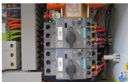
Figure 7 – Interrupteur général OFF Figure 8 – Interrupteurs de circuit OFF
