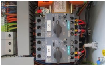
Рис. 12 – выключатель насоса ВКЛ.
