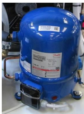
Abbildung 17– Kompressor Platzierung für CCE 6101 – 6201 – 6301
